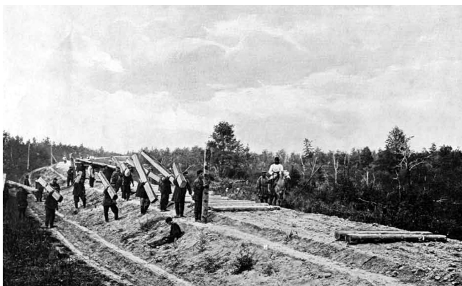
Строительство железной дороги в конце XIX века.
