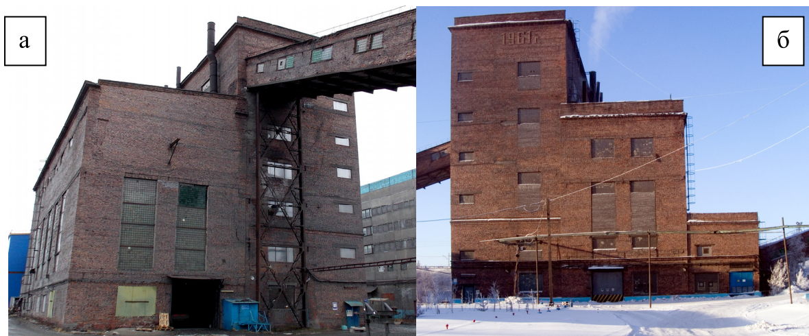
Рис. 1. Объекты экспертизы промышленной безопасности в горнорудной промышленности: а – корпус мелкого дробления Дробильно–обоганительной фабрики АО «Оленегорский ГОК», б – корпус среднего дробления Дробильно–обоганительной фабрики АО «Оленегорский ГОК»
